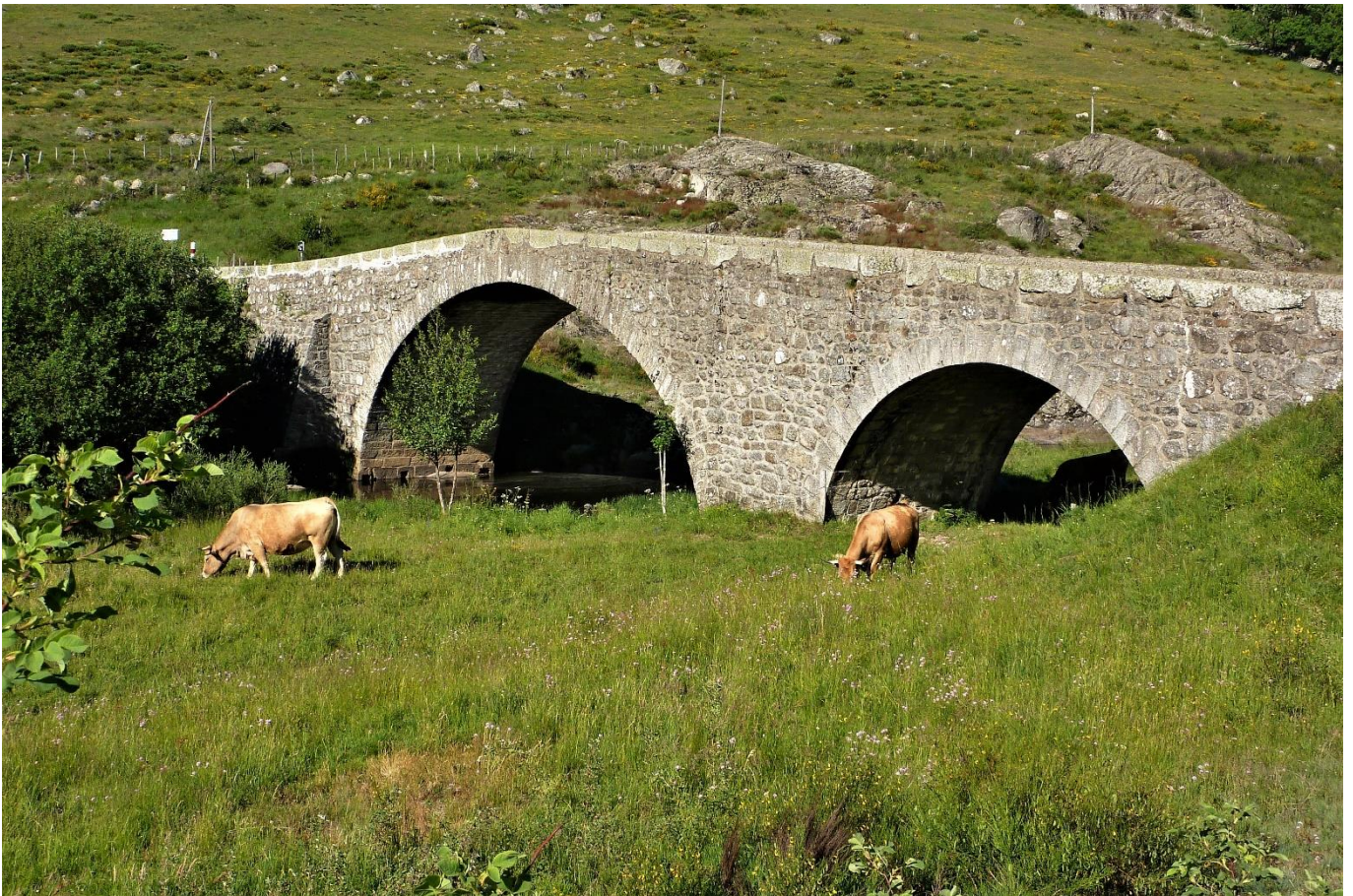
Sous le Pont de Gournier coule le Bès
